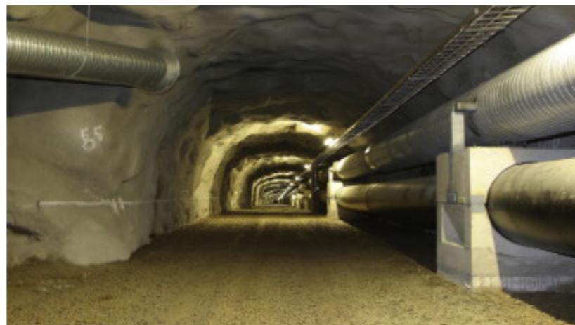
ტიპური მიწისქვეშა გვირაბი საინჟინრო ქსელებისათვის. ფოტო ჟორბა ვილაჰანი
